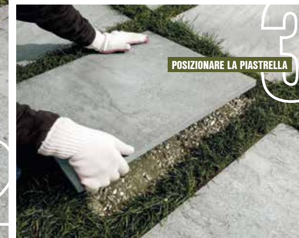
VERSARE LO STABILIZZANTE DI GHIAIA E SABBIA PER MIGLIORARE LA TENUTA DEL SOTTOFONDO
